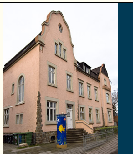
Das ehemalige "Haus International" in der Rathausstraße in Sieglar. Foto Dietrich Hackenberg
