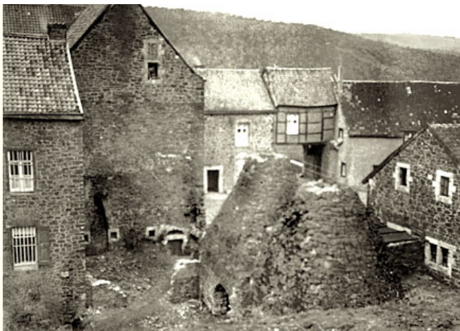
Neuenhammer um 1923. Im Vordergrund die trichterförmigen Frischhöfen zum Erhitzen des Eisens. Das Eisenwerk der Reitmeisterfamilie Hoesch steht unmittelbar am Vichtbach. Die Hammerwerke sind mit Wasserrädern angetrieben worden. Archiv Katharina u. Helmut Schreiber, Stolberg.
