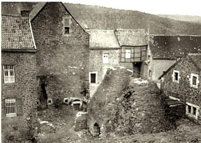
Neuenhammer um 1923. Im Vordergrund die trichterförmigen Frischhöfen zum Erhitzen des Eisens. Das Eisenwerk der Reitmeisterfamilie Hoesch steht unmittelbar am Vichtbach. Die Hammerwerke sind mit Wasserrädern angetrieben worden.
